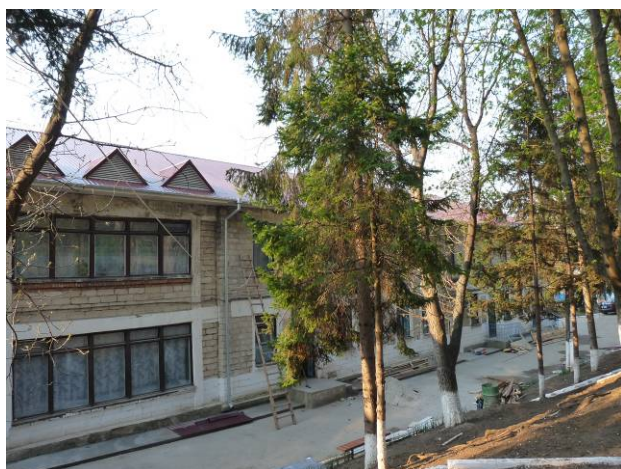
Fertigstellung des Schuldaches
