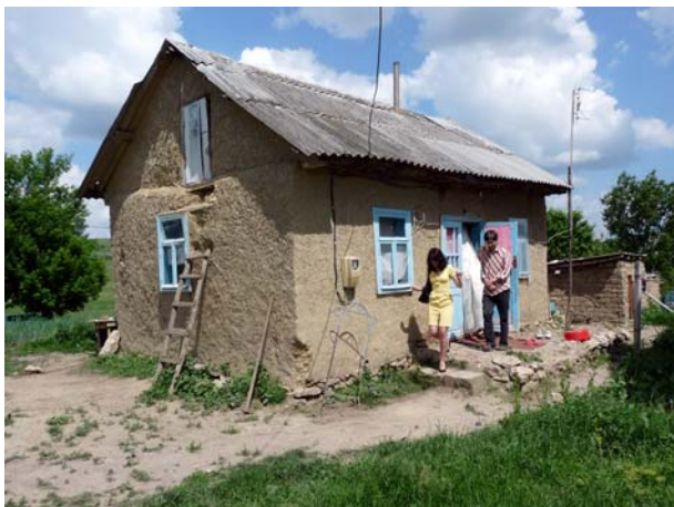
Das Haus vor der Außenisolation
