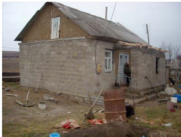
Das Haus nach der Vollendung der Bauarbeiten
