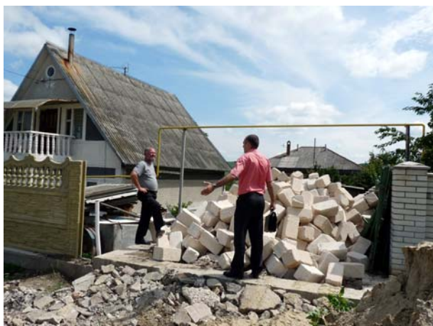
Vorbereitung zu Bauarbeiten
