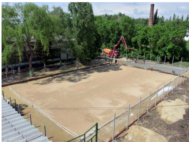
Bau des Untergrundes
