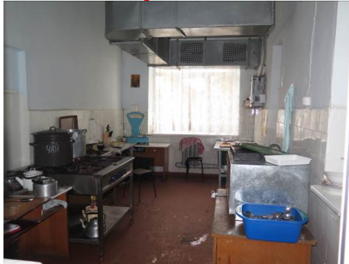
Inainte de reparatie
