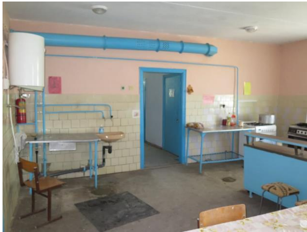
Înainte de reparații
